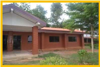
อาคารอำนวยการ
